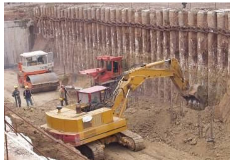
Метро станица 10-примена на пилоти
