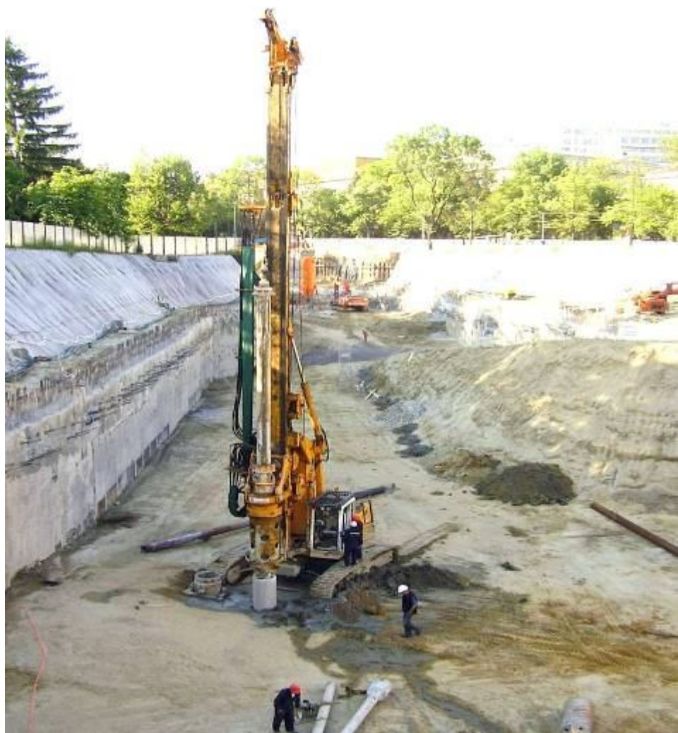
Метро станица 9-примена на пилоти
