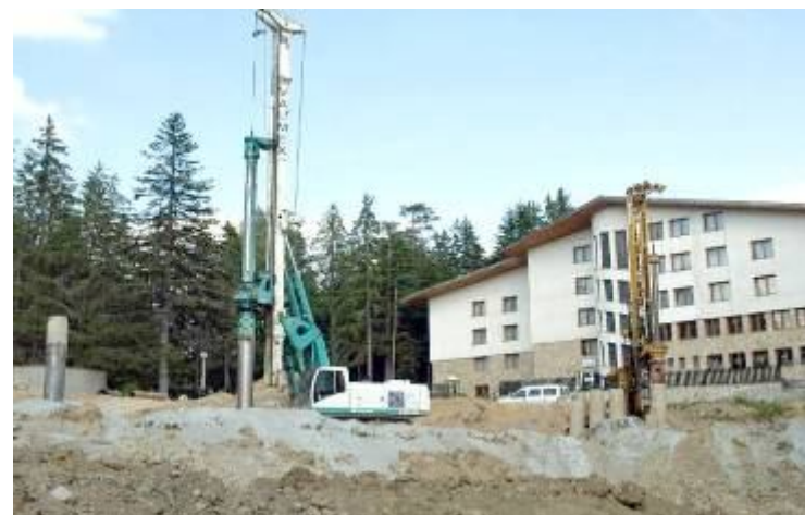
Примена на пилоти со Ф500mm во Боровец
