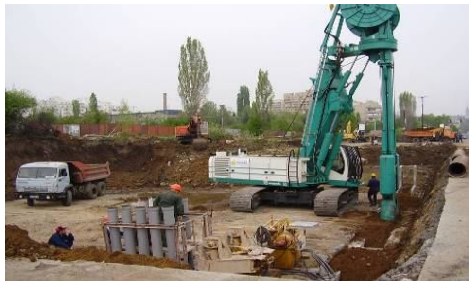
Метро станица 11-изведба на жлебни сидови со d=0,60\text{м} – 8675 \text{м}^2 и d=0,80\text{м} – 2188 \text{м}^2 и армиран бетон 3045 \text{м}^2 .
