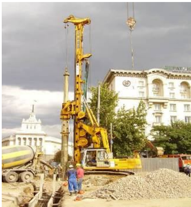
Изведба на Метро станица 7-Метро проширување Софија
