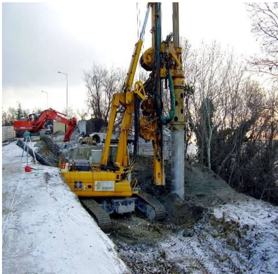
Свлечиште Свети Никола – изливни пилоти за бушење Ф 800
