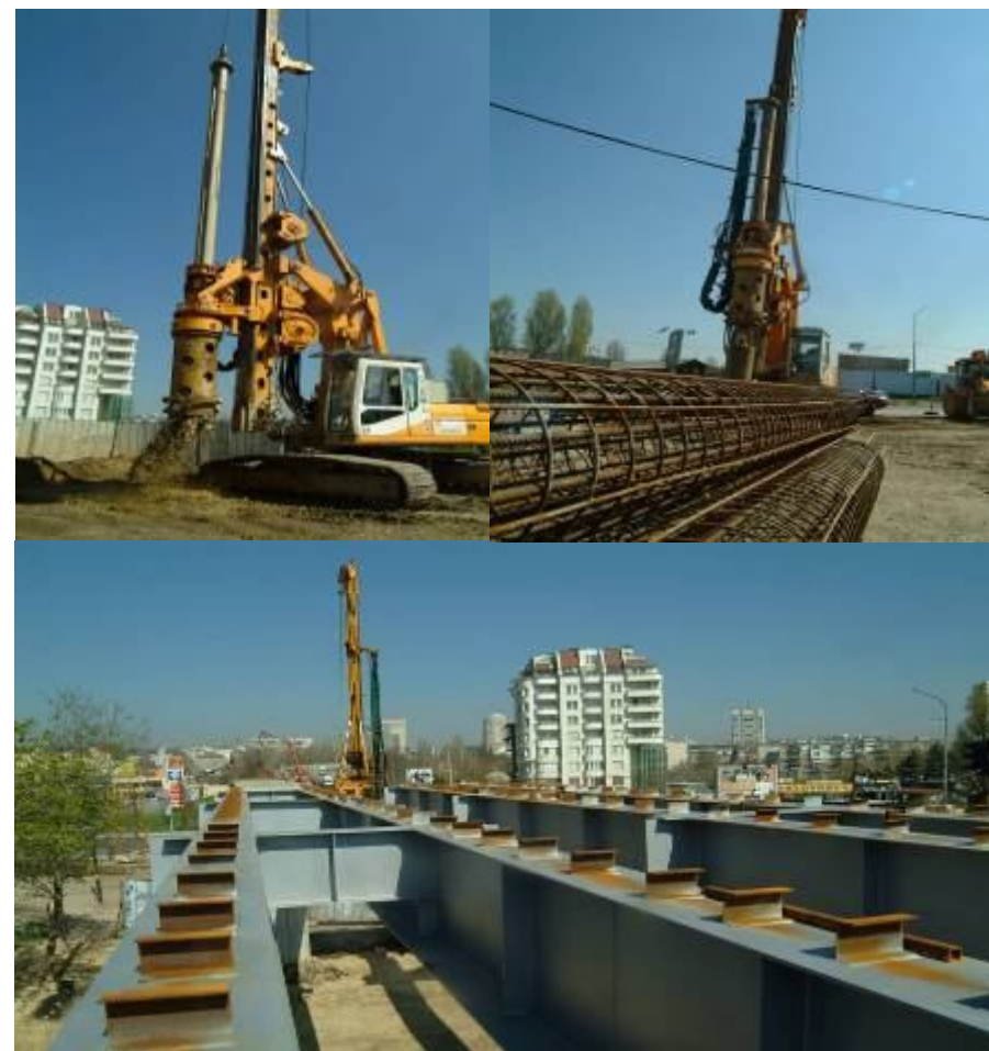
Продолжување на Метро Софија - градежни работи на дел од метро км12=+ 995 до13+ 199 км13 - изведба на леани пилони Ф800 - 94 бр.
